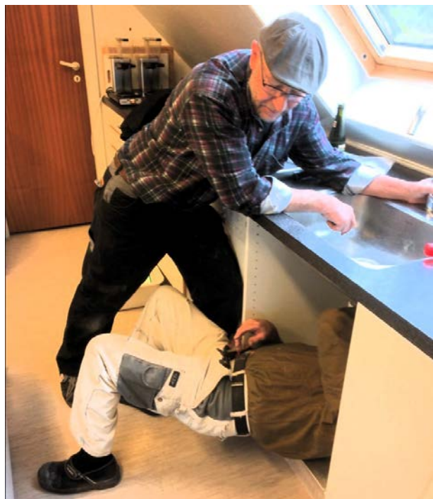
Hans Nielsen prøver, om installationen er tæt. Det håber KJ i hvert fald. Foto: Kurt Nielsen
