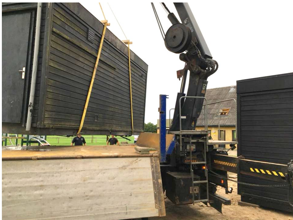
Kranen fra Troels Jørgensen A/S kom på arbejde, da Karsten Hansen flyttede de 3 skure.
